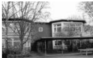
In Pavillon III der Grundschule am Halmerweg versteckt sich vorläufig die Oberschule Ohlenhof mit 50 Schülern in zwei Jahrgängen.
