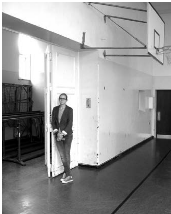
Alte Sportgeräte und schräge Basketballkörbe in der Oberschule Gröpelingen. Elke Wolf-Rooney: Komplettisanierung nötig
