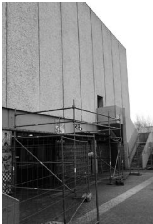
Langzeitbaustelle Sporthalle der Gesamtschule West
