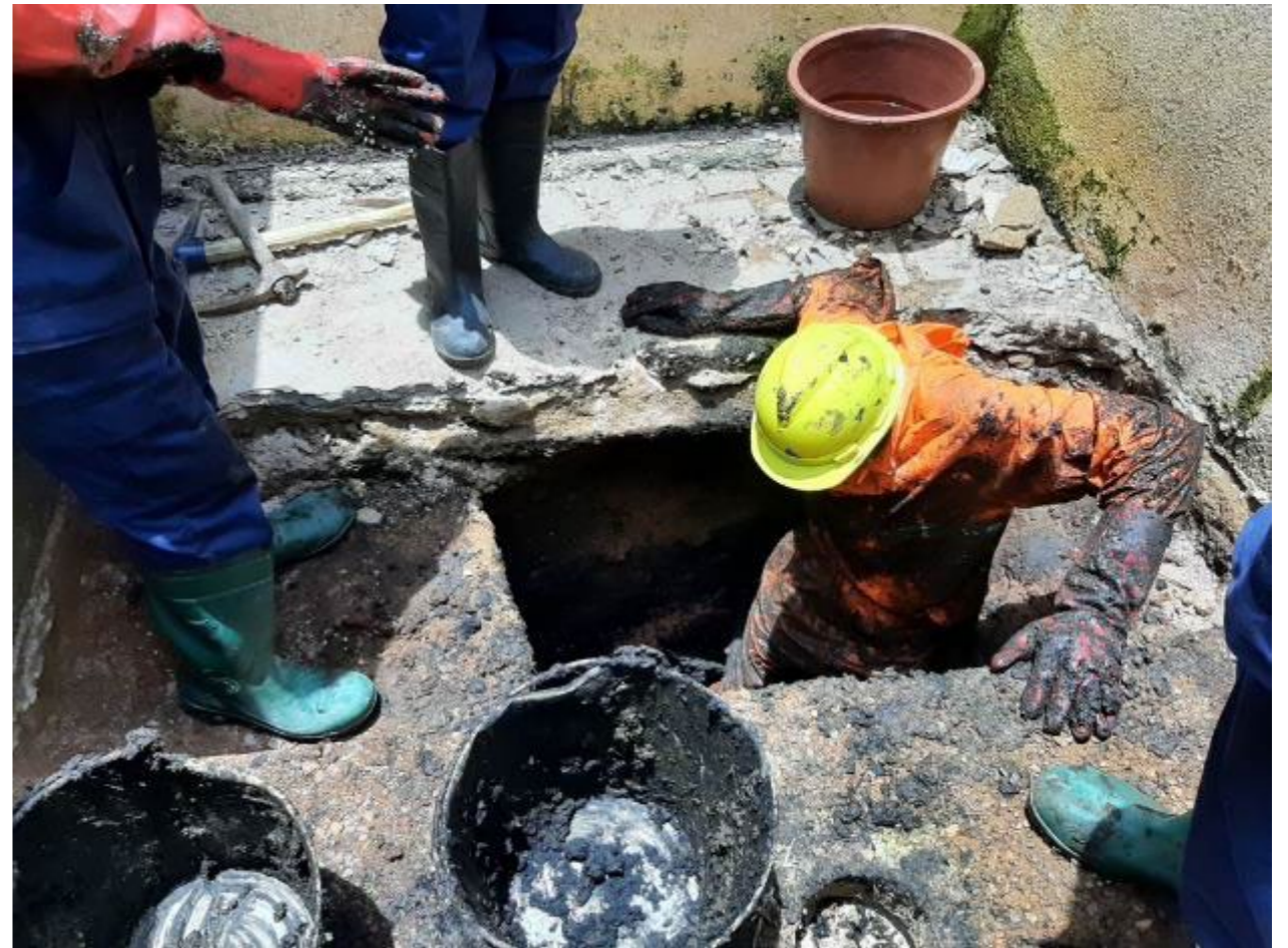
Mali: Training mit Dienstleistern zur manuellen Entleerung von Schlammgruben. Foto: © BORDA
