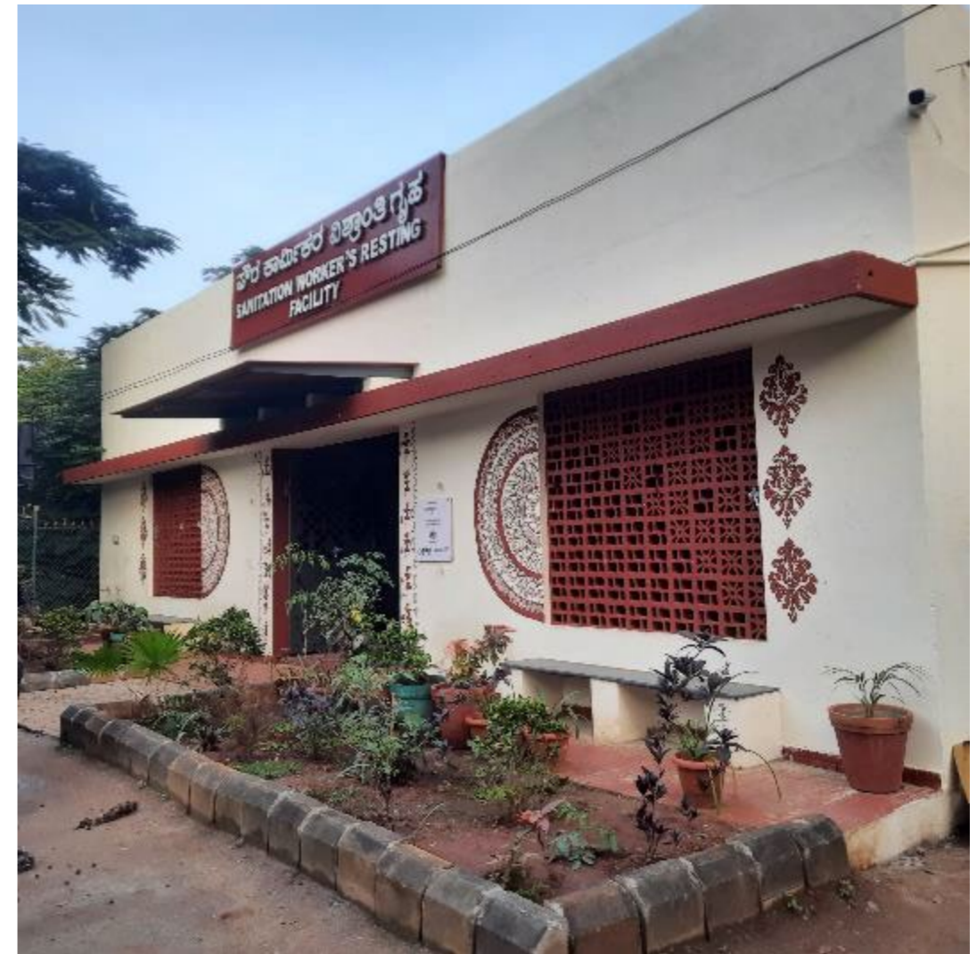
Indien: Bau einer Rückzuckmöglichkeit für Sanitation Workers in Chintamani. Foto: © BORDA
